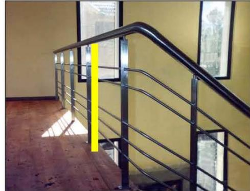
b) En caso de contar con pasamanos sujetos a la pared, deben estar fijados por medio de anclas aseguradas en la parte inferior. Dichas anclas deben estar empotradas en la pared y tener la longitud suficiente para que exista un espacio libre de por lo menos 4 cm entre los pasamanos y la pared o cualquier saliente, y no se interrumpa la continuidad de la cara superior y el costado del pasamano.
